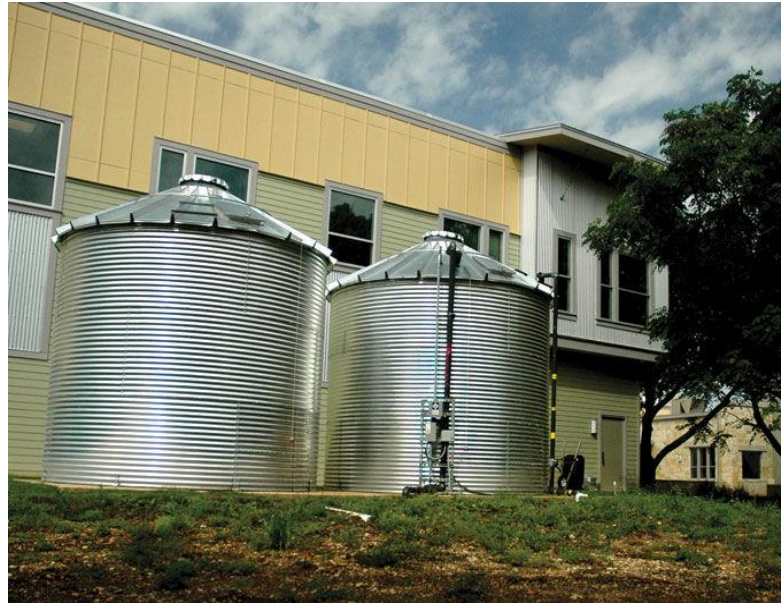
Şəkil 2. Texas ştatı, San Antonioda həm yağış suyu tutan, həm də suvarmada istifadə olunan kondensat
